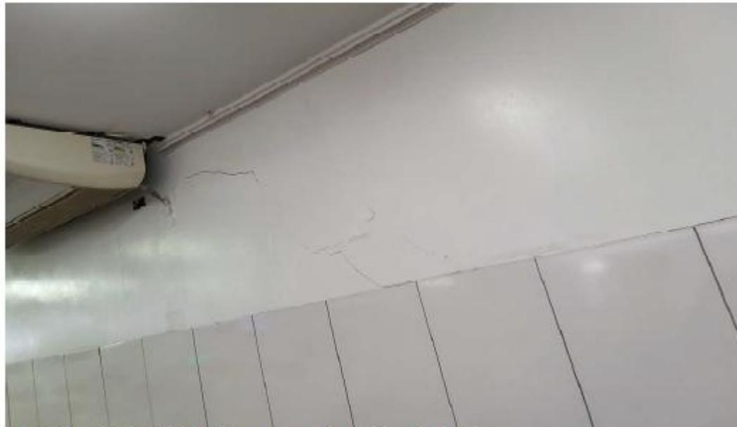
**FOTO 04 – HEMODIALISE (trincas na parede próximo do forro)**
