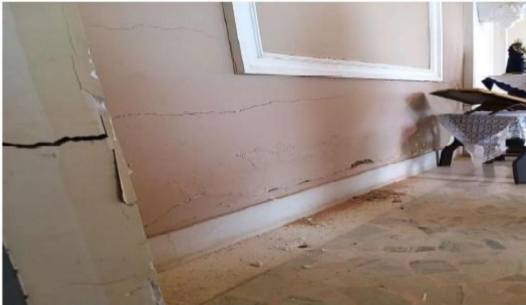
FOTO 01 – CAPELA (trincas e rachaduras)
