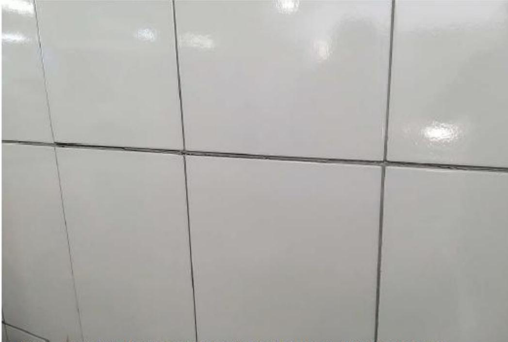
**FOTO 03 – HEMODIALISE (trincas no revestimento da parede) – Divisa com a Capela**
