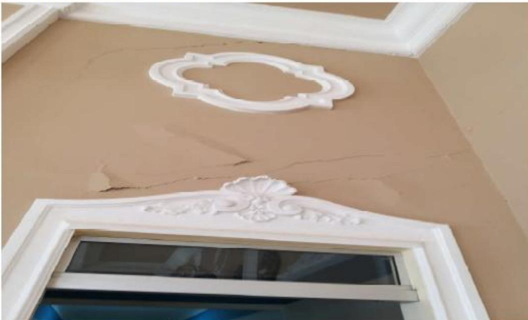
FOTO 02 – CAPELA (trincas próximo ao forro)
